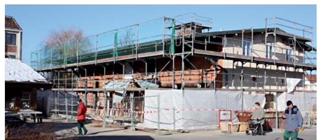
Momentan eine Baustelle, das Neuerkeröder Dorfgemeinschaftshaus
